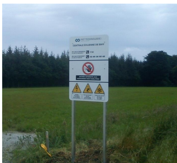
Figure 11 : un exemple de panneau de prévention des risques sur un parc éolien
